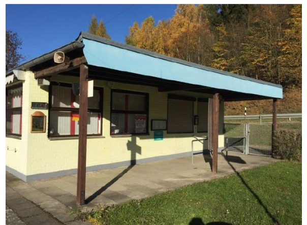
Abbildung 10, Eingangsbereich mit Kiosk
