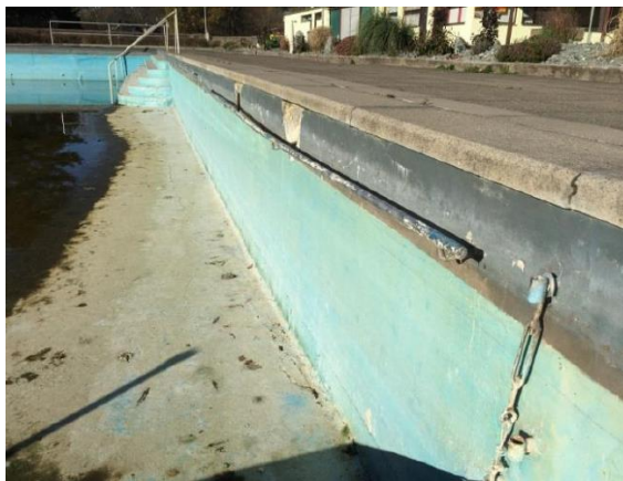
Abbildung 7, Schäden Beckenrand
