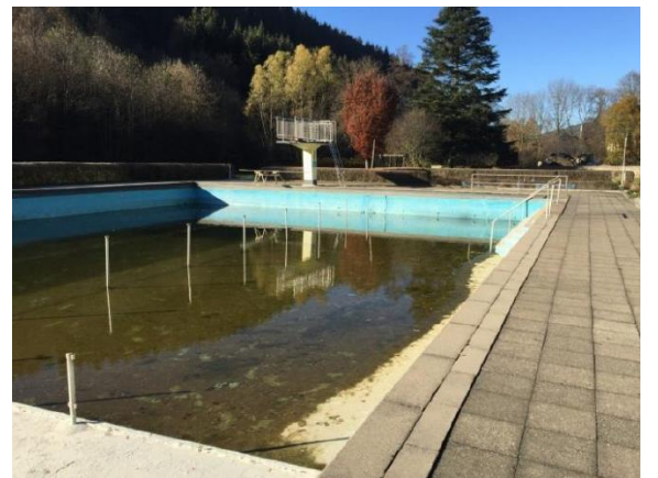
Abbildung 8, Zugang Nichtschwimmer, Beckenumgang
