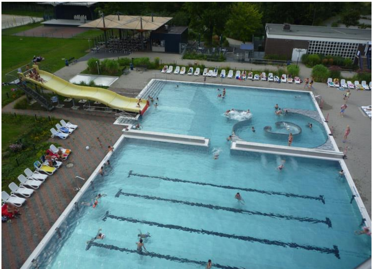
Abbildung 17, Beispiel Freibad mit Edelstahlauskleidung des Schwimmbeckens und Einbauten
