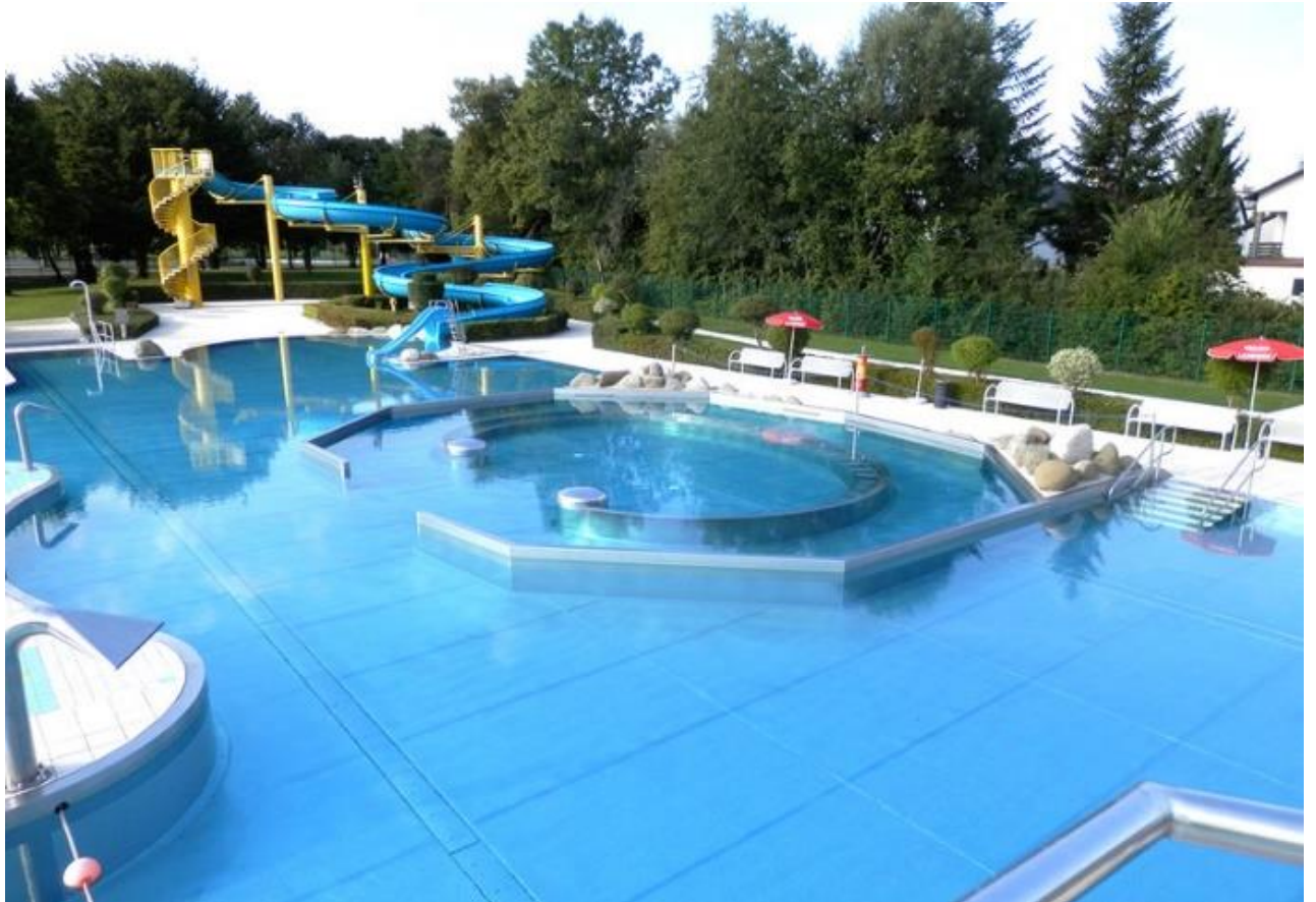
Abbildung 16, Beispiel Freibad mit Edelstahlauskleidung des Schwimmbeckens und Einbauten
